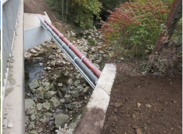
Exemple d'encorbellement déporté
