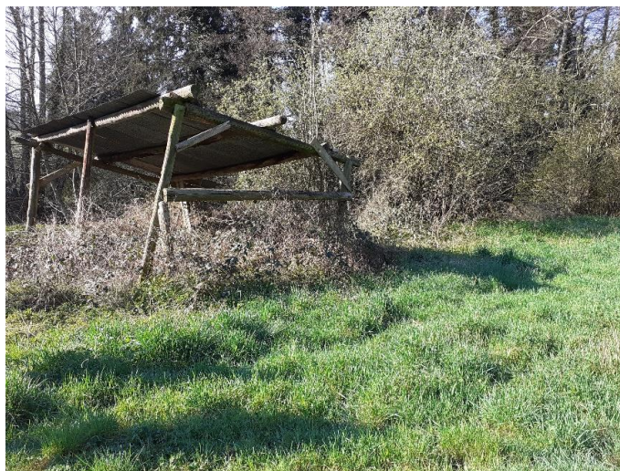
Cabane à démolir
