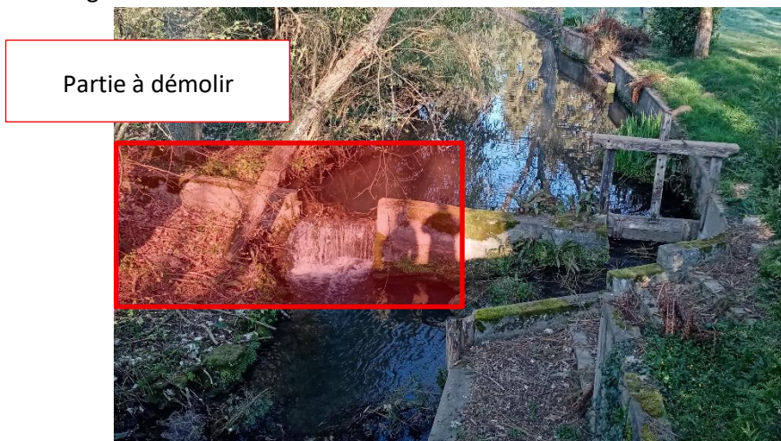
OH34 à démolir partiellement
