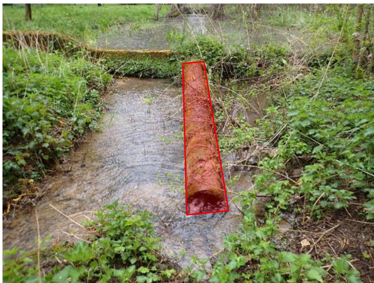
Busage à démolir
