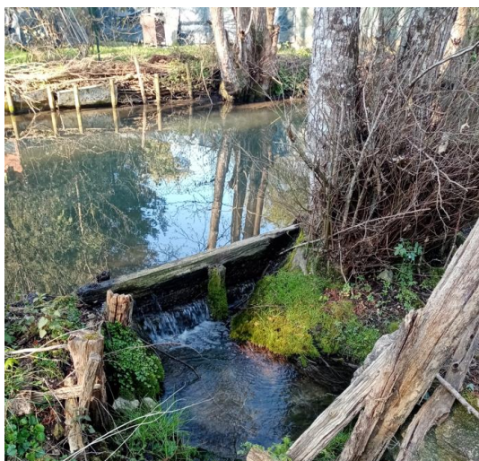
Comblement du bras passant par l'OF16 Tan (aval de l'OH4) à la suite de la création de la nouvelle connexion (vue vers le sud)
