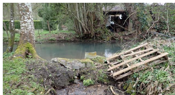
Aménagement de l'ouvrage OH5
