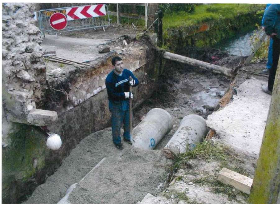
Illustrations de la construction du pont busé OF1 à démolir et à remplacer par un dalot/pont cadre
